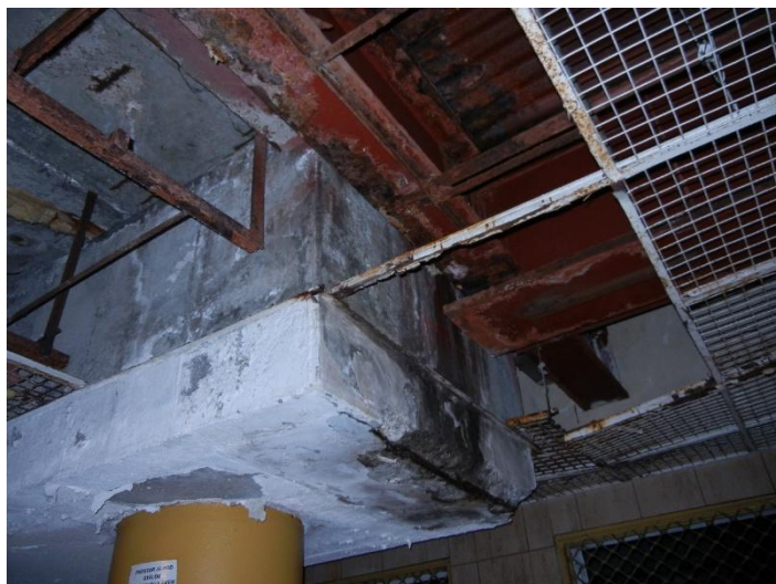
detail spáry ocelová část x nosníky KA (levá spára)
